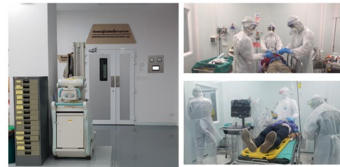
ห้องแยกโรคความดันลบ (Negative Pressure Room ) ประตู 2 ด้าน เข้าด้านในห้องฉุกเฉินและด้านหน้าออกห้องฉุกเฉิน โดยผ่านห้องเตรียม (Ante Room)
